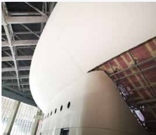
亚运会场馆无木吊顶系统照片
