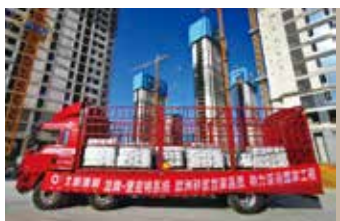
龙牌堡密特砂浆系统服务亚运会场馆建设
