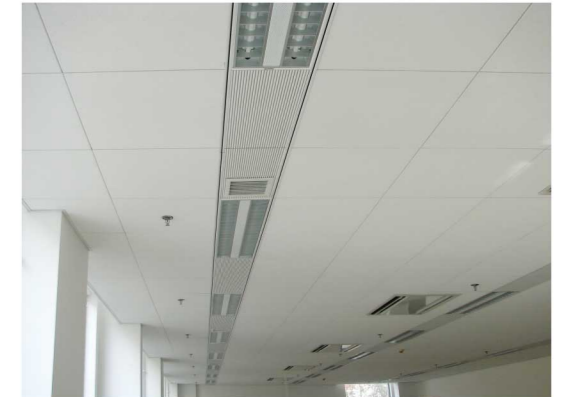
中国建筑工业出版社办公楼内景 (20000m 2 , 米兰花, 明暗架配套龙牌窄边平面烤漆龙骨)
