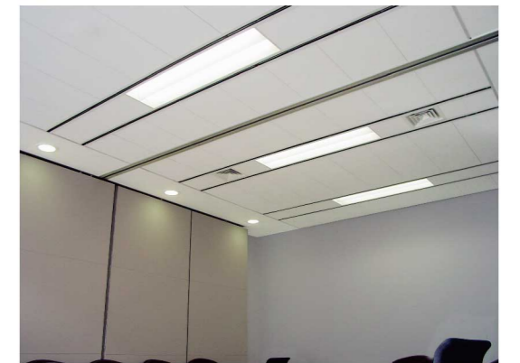
上海虹桥机场内景 (40000m 2 , 跌级米兰花 / 超越暗插米兰花条板, 明暗架吊顶系统)
