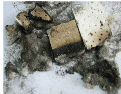
珍珠岩体系的矿棉板燃烧粉化后实景
