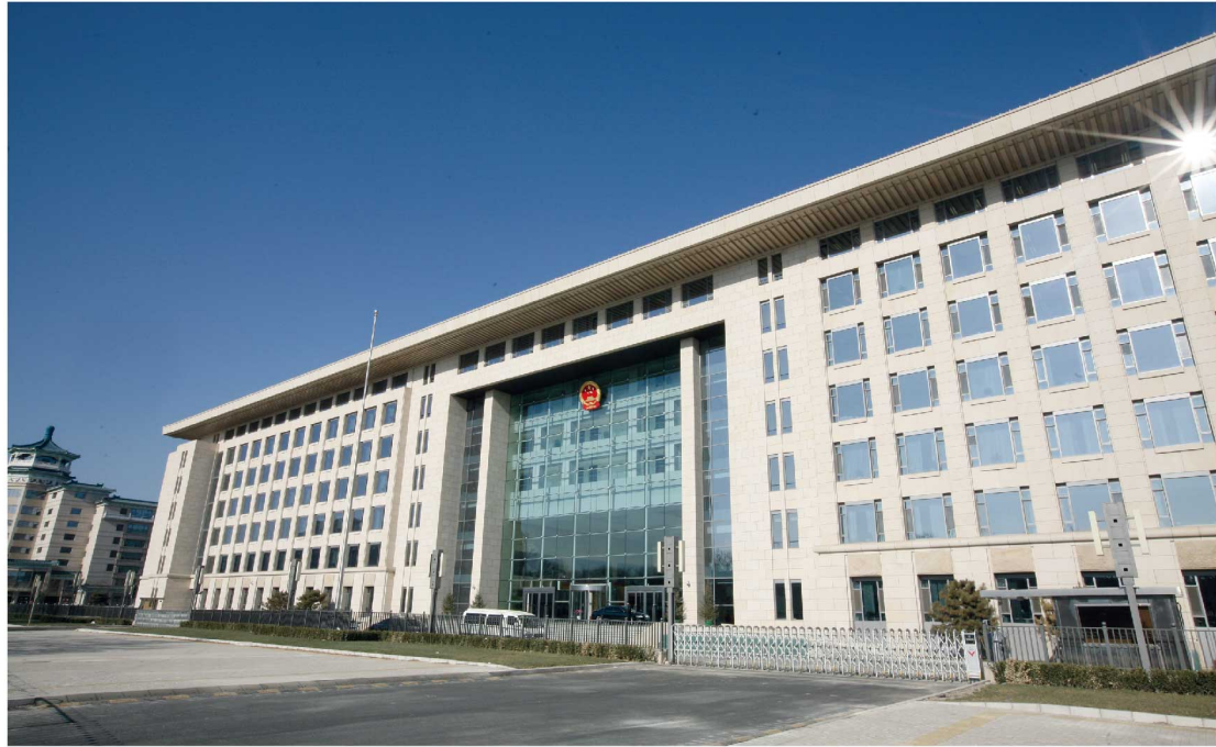
全国人大机关综合办公楼 (45000m 2 , 跌级米兰花, 配套龙牌 38 立体凹槽龙骨)
