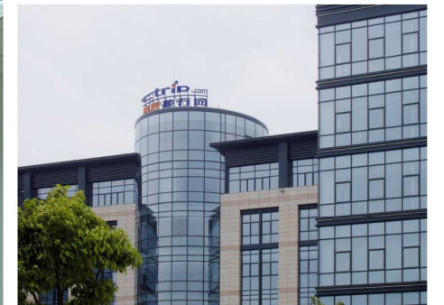
上海携程网络技术大楼 (23000m 2 , 平板米兰花, 配套龙牌 38 平面烤漆龙骨)
