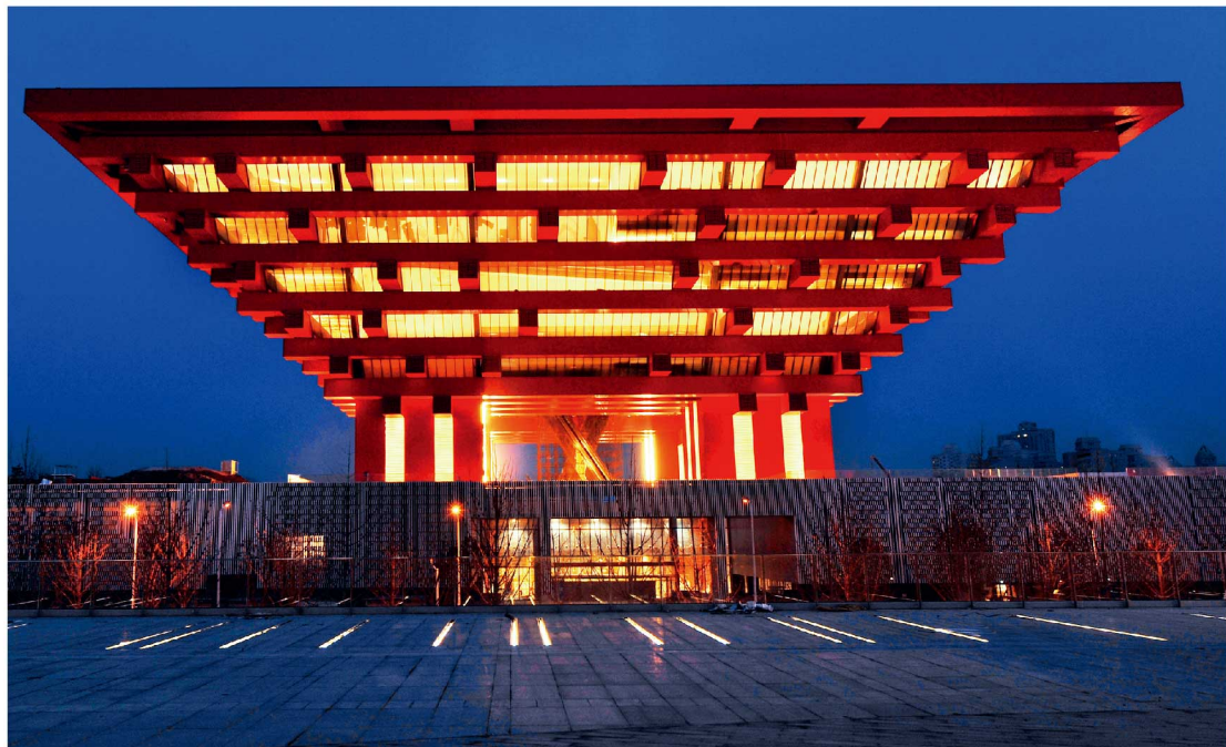
上海世博会中国馆 (5000m 2 , 满天星, 复合平贴吊顶 / 贴墙系统)
