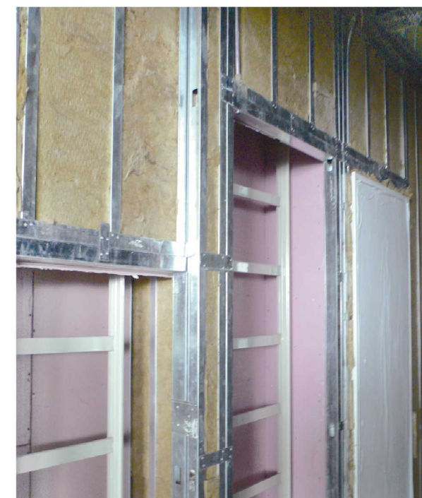
龙牌岩棉制品应用于上海环球金融中心走廊防火墙系统
